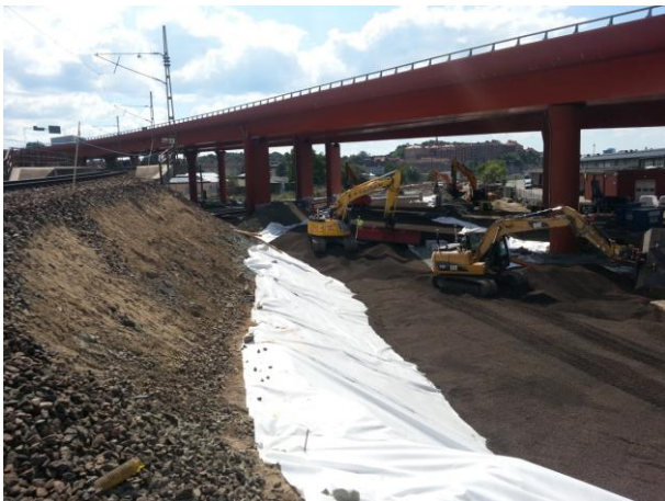
Figur 13. Utläggning av lättklinker för spår 88 och 91 under PHB. T.v. är landfästet upp mot Skäran bron.
